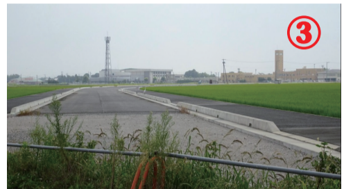
熊谷市大里地区 大里中学校付近青山熊谷線の工事
