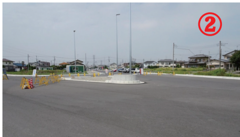
熊谷市上之地区 車線工事進行中
