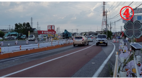
熊谷市箱田地区 太田熊谷線の道路拡張と橋梁工事
